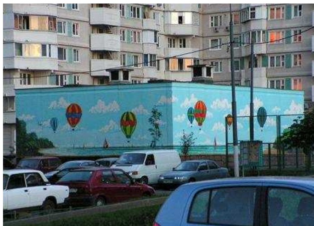
Рис. 1. Центральный тепловой пункт (ЦТП), фото с сайта www.severnoebutovo.ru
