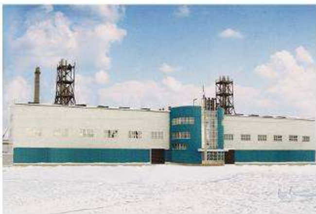
Рис. 3. Газопоршневая Зауральская ТЭЦ Фото из журнала «Новости теплоснабжения»
