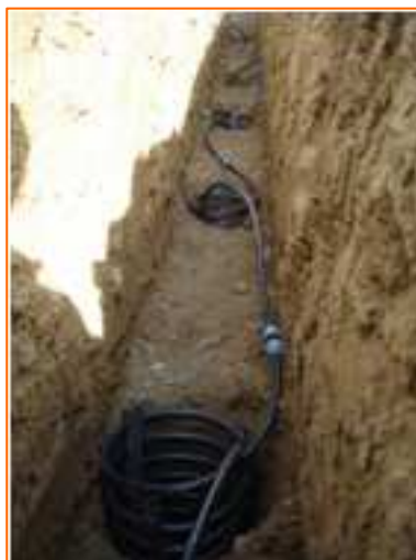
Фото 6. Коллекторы в траншее
