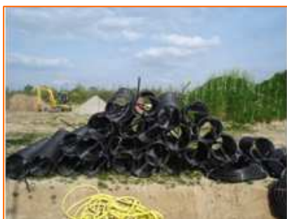
Фото 4. Коллекторы перед закапыванием
