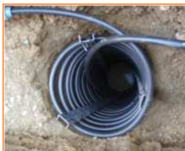
Фото 5. Коллектор в земле
