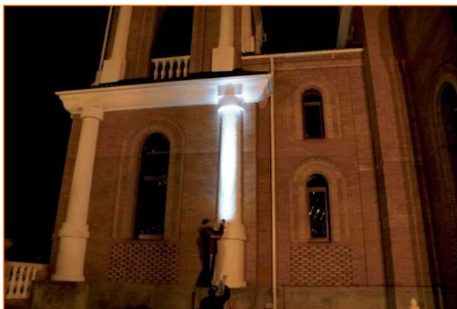
Фото 2. Подсветка колонны здания при помощи светодиодного прожектора
