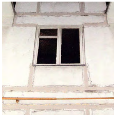
■ Межблочные швы требуют обязательной герметизации
