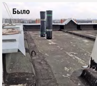
Состояние крыши до ремонта (6,5 лет после постройки) и после ремонта в 2008 году [общая площадь отремонтированной кровли — 1025 м 2 ; стоимость ремонта — 480 тыс. руб. (468 руб./м 2 ); срок службы материалов — 15 лет]
