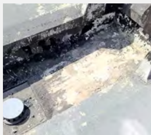
Состояние крыши до ремонта (6,5 лет после постройки) и после ремонта в 2008 году [общая площадь отремонтированной кровли — 1025 м 2 ; стоимость ремонта — 480 тыс. руб. (468 руб./м 2 ); срок службы материалов — 15 лет]
