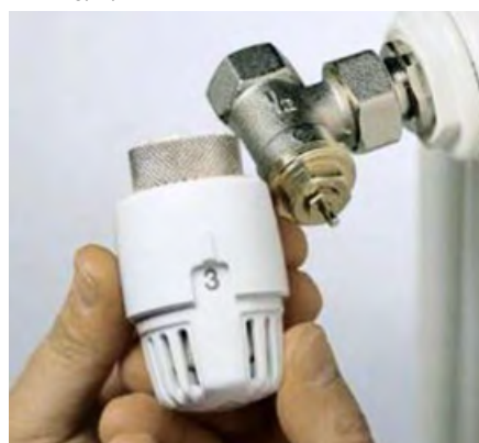
Рис. 4. Замена ручки управления на термостатическую головку
