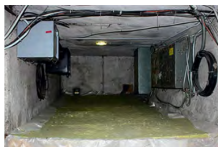
■ Отличное состояние утепленного чердачного помещения
