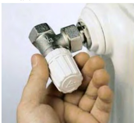
Рис. 4. Замена ручки управления на термостатическую головку
